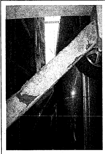
駐車場に吹き付けられたアスベスト含有吹付け口 ツクウール。損傷・欠損がみられる。
