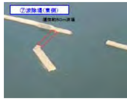
新湊地区波除堤の決壊
