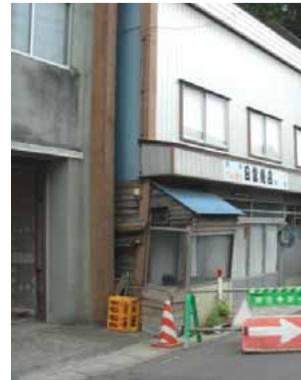
がけの変動によりが家屋(住民避難中)の1階が押し出されたため、県道を片側交互通行規制
