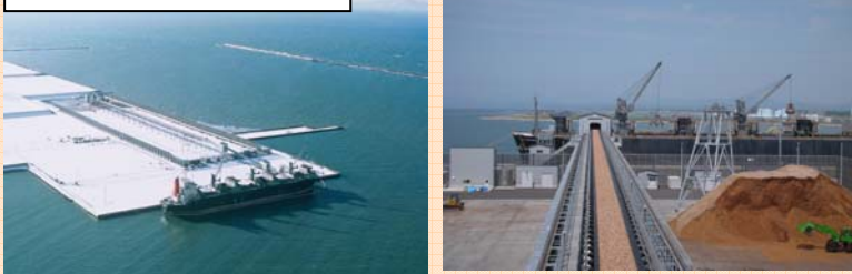
西地区多目的国際ターミナル
