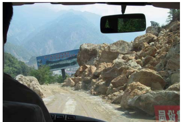
落石による道路損傷（北川県）
