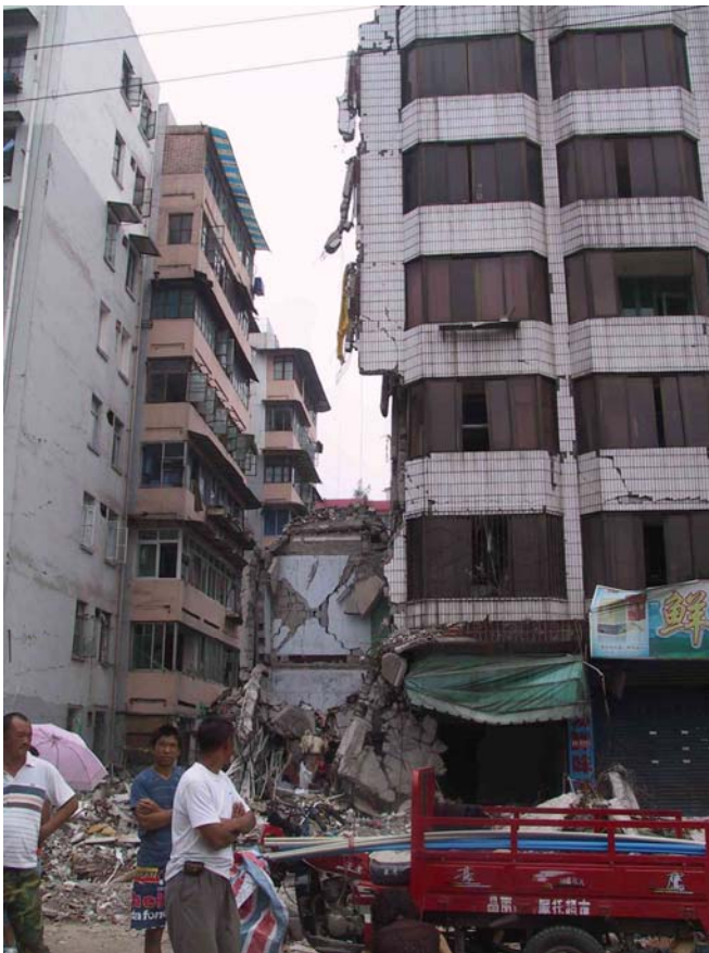
一部が崩落した建築物（漢 旺 鎮） かんおうちん
