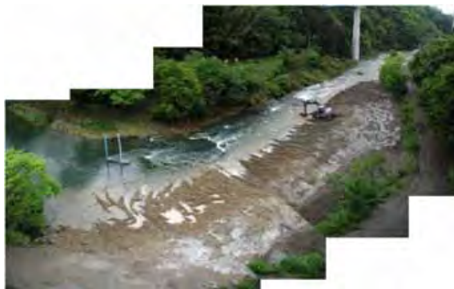
フラッシュ放流及びダム直下における土砂の投入
