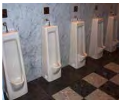
雨水を利用したトイレ
