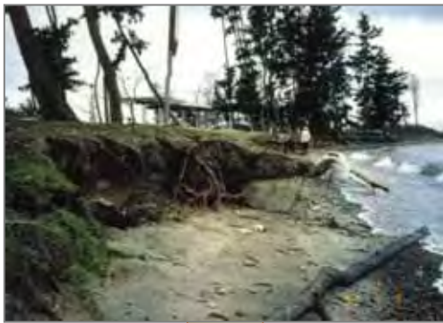
【新海浜地区の侵食】
