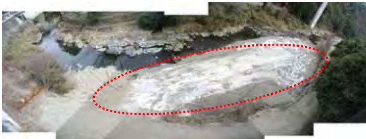
ダム下流河川への土砂供給実施事例（一庫ダム）
