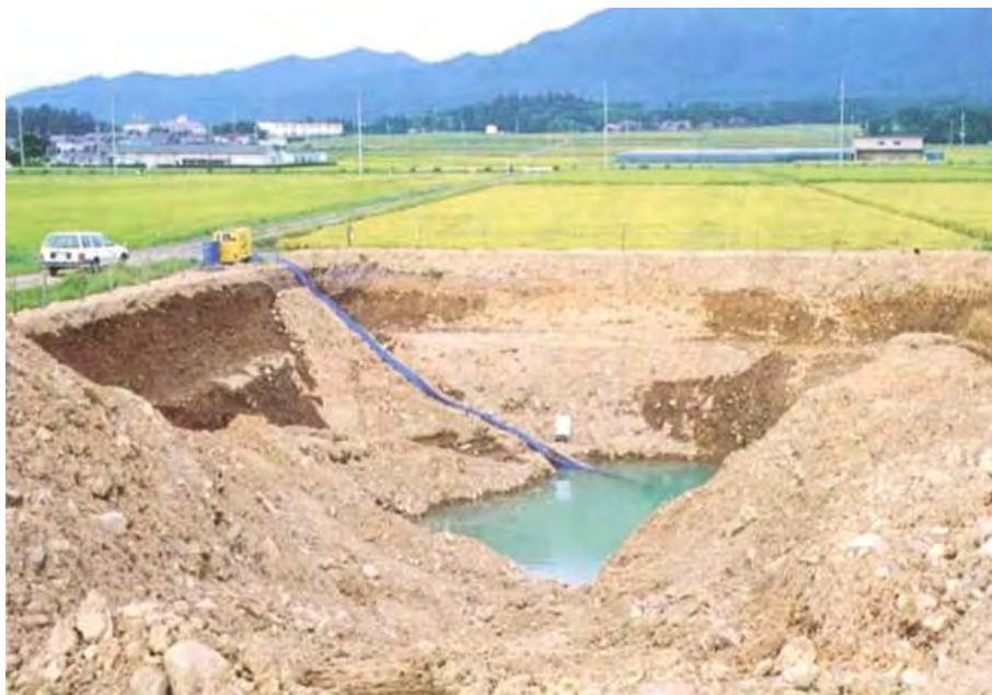
[応急対策状況] (滋賀県東近江市(旧八日市市)) 地下水利用による水の確保
