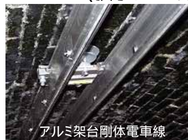
剛体電車線とカテナリ式電車線の比較
