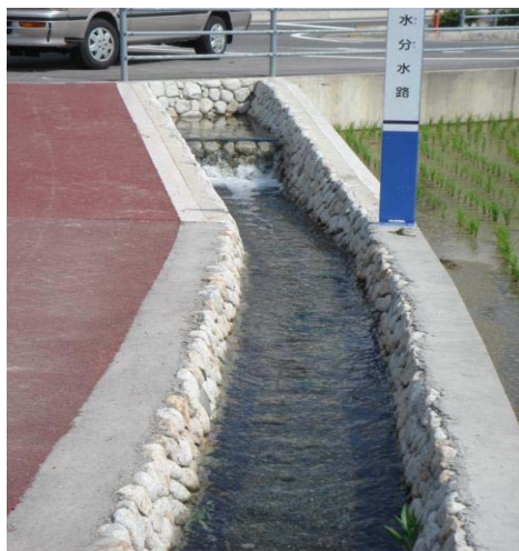
下水再生水をため池に送水する水路
