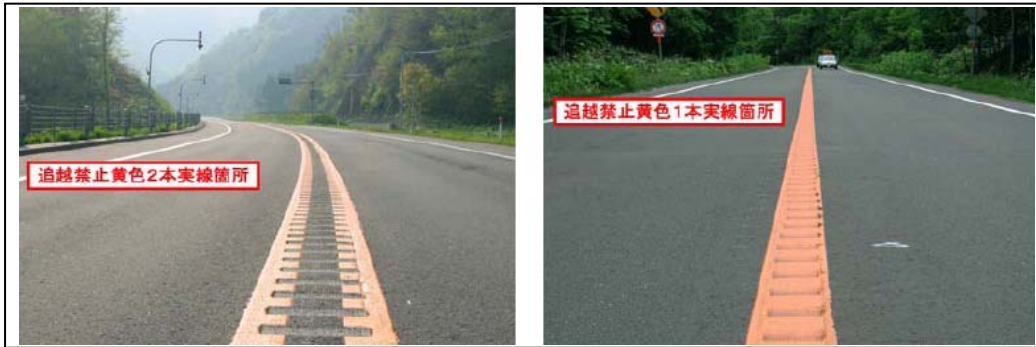
ランブルストリップス（センターライン対応型） 施工例
