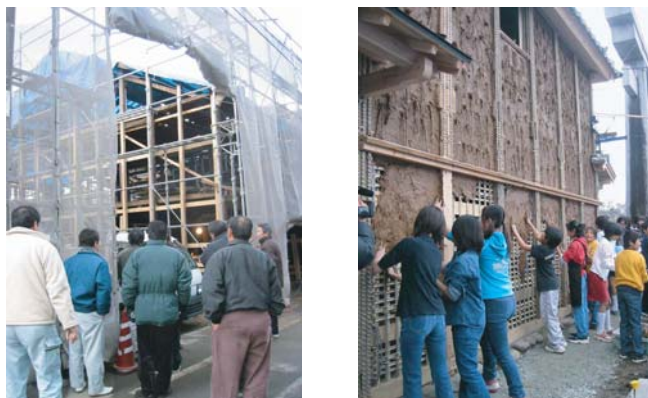
▲ 写真左: 建築集団のNPOが修理技術等の向上のため実施している現場研修会の様子。写真右: 小学生による伝統的建造物の修理体験学習の様子(伝統工法による土壁塗り)。
