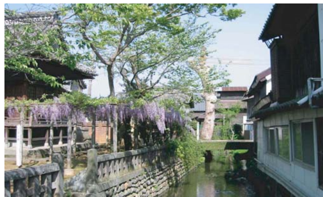
▲ 旧城下町時代の外堀の遺構。現在は水路として機能しており、護岸は伝統工法の切石積みや玉石積みとなっている。
