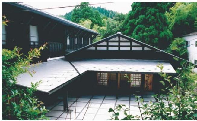
▲ 街なみ環境整備事業で建設された多目的集会施設「べっちゃん館」。
