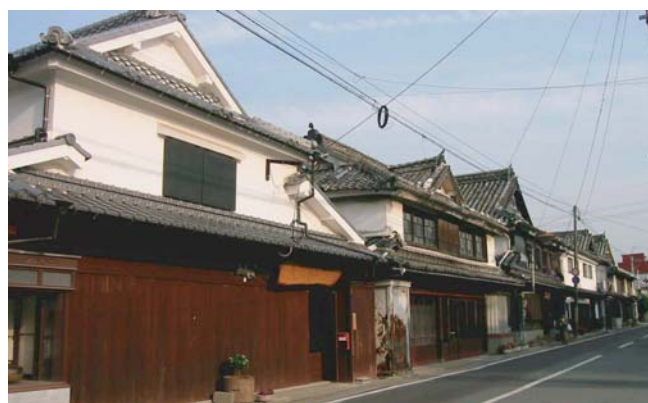
▲ 旧往還道は、明治と昭和初期の2回拡幅工事が実施され、1階の下屋庇が切断された固有の景観を形成している(東宮野町)。
