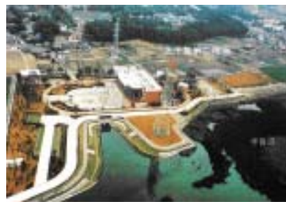
揚水機場の例
