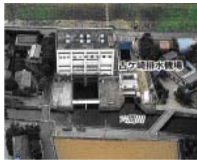
排水機場の例
