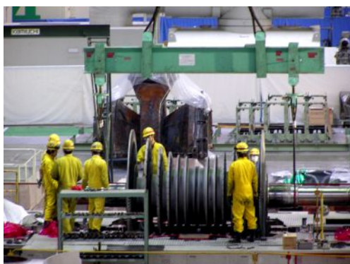
【写真-45 川越町・川越火力発電所】
