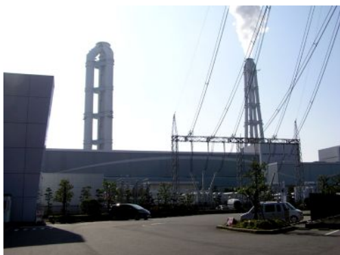
【写真-43 川越町・川越火力発電所】
