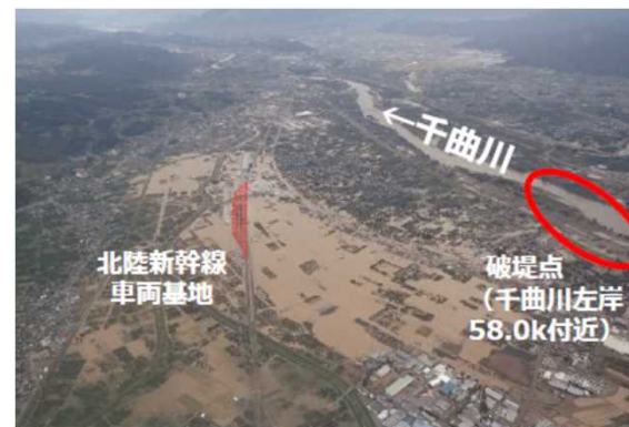
令和元年台風第19号による洪水被害 (信濃川水系千曲川 (長野県長野市))
