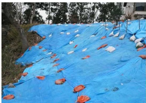
シート被覆工
