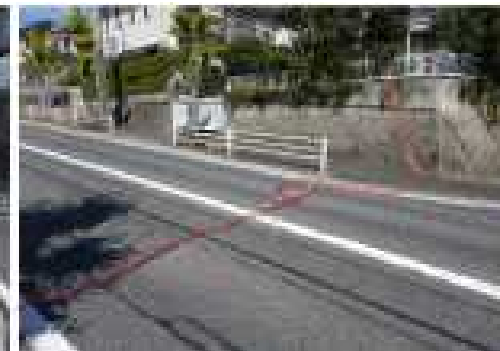
②擁壁から路面に至る連続したクラック (その2)
