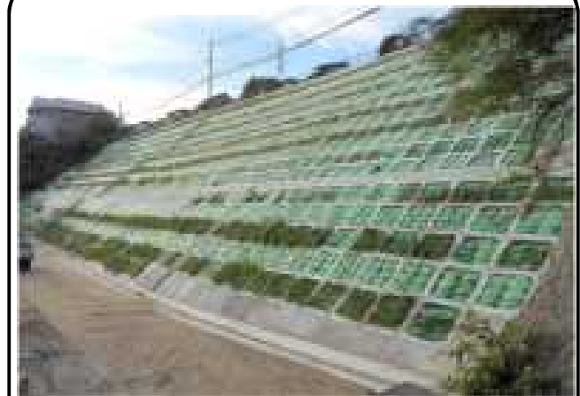
対策工事(平成29年7月~平成30年10月)
