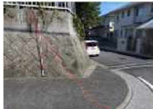
②擁壁から路面に至る連続したクラック (その2)
