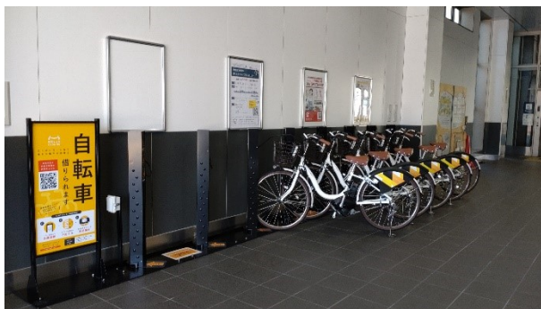
東岡崎駅構内チャージャーステーション
