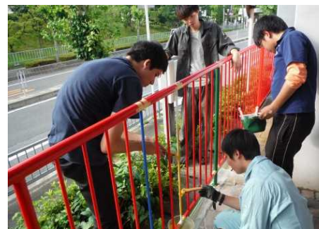
関西大学の学生が改修作業を行う様子
