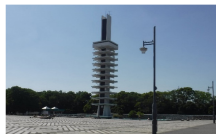
管制塔(駒沢オリンピック公園)【世田谷区】 本施設は、電気、電話、給水塔の設備機能を集中させ、公園の管理を経済的かつ合理的に実施できるようにするとともに、公園の中央広場の焦点・シンボルとして、オリンピック開催を記念するために整備された。
