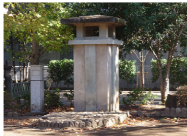
ラジオ塔(調公園)【さいたま市】 昭和15(1940)年に日本放送協会より寄贈されたラジオ塔は、現在では本来の機能は無いものの、当時の姿を残している。
