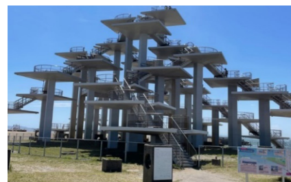
明治百年記念展望塔(千葉県立富津公園)【富津市】 県内初の広域公園として明治百年記念公園の指定を受けて整備された。公園のシンボルとなる記念施設として展望塔が整備された。
