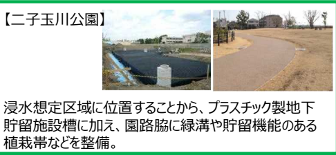
【二子玉川公園】 浸水想定区域に位置することから、プラスチック製地下貯留施設槽に加え、園路脇に緑溝や貯留機能のある植栽帯などを整備。
