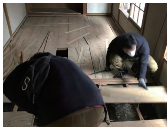
岩地域の物件における床工事の様子
