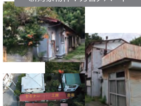
新対象物件：力石アパート
