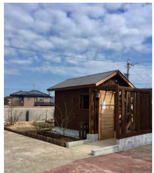
完成したトイレ
