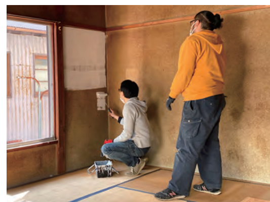
岩地域の物件における壁工事の様子
