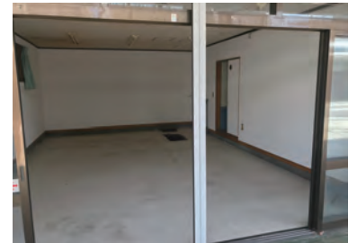
改修前の対象物件
