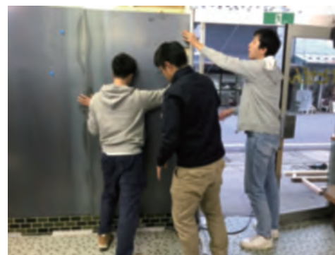
内装工事の様子
