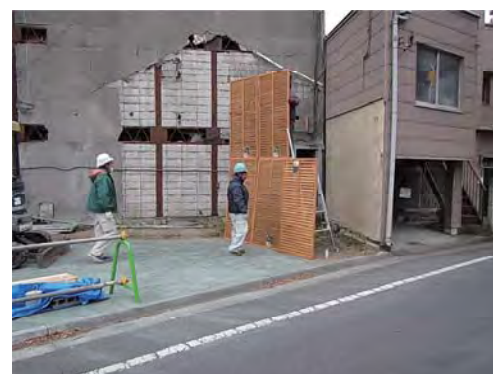
フェンスの設置工事の様子
