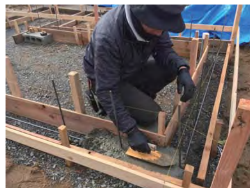
コンクリートを打ち込む様子
