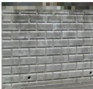
補強鉄筋を用いたコンクリートブロック造擁壁（C P 型枠擁壁の例）
