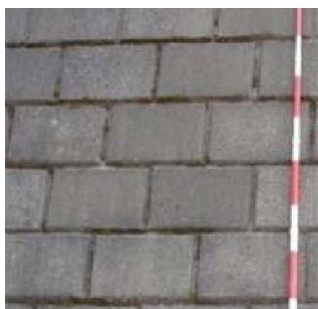
間知ブロック積み擁壁（平積） 1)
