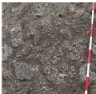
ガンタ積み擁壁 1)
