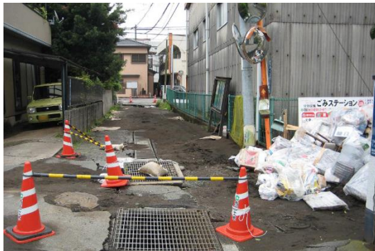
図-1 道路上への噴砂の堆積（熊本市）
