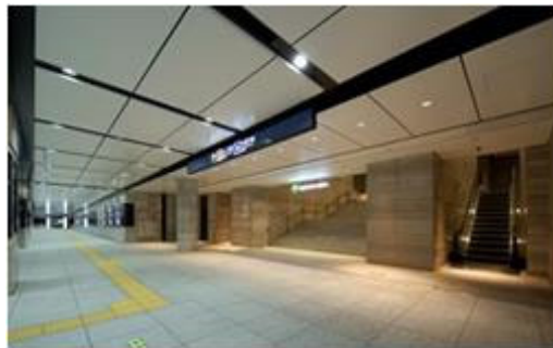
図参考 2-10 地下鉄コンコース拡張部
