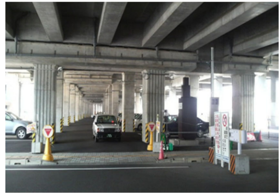
図参考 2-17 高架下を利用したタクシープール
