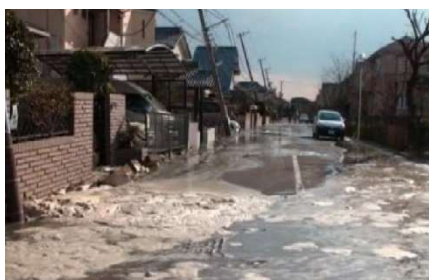
写真-1.1 道路亀裂からの大量の噴水
