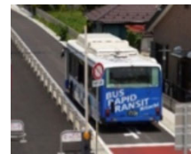
専用空間に他車線からの侵入を防ぐ分離施設 (日立市) ※7
