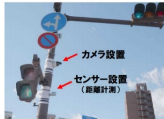
センサー及びカメラの設置状況（前橋市）
