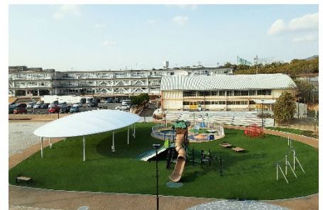
旧小学校施設を多世代交流拠点施設に大規模改修した事例（春日井市）
