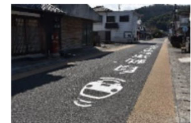
自動運転車両が走行することを明示する路面表示 (芦北町) ※7
