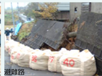
擁壁の防災対策
