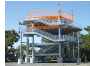
津波避難タワー
