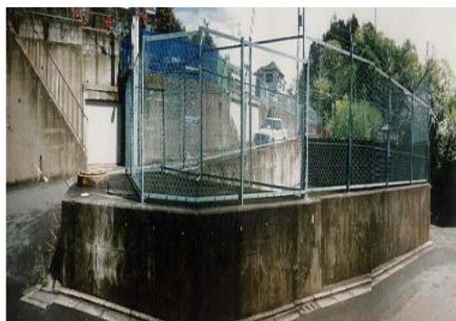
従前の防災調整池
