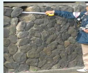
擁壁の危険度調査
