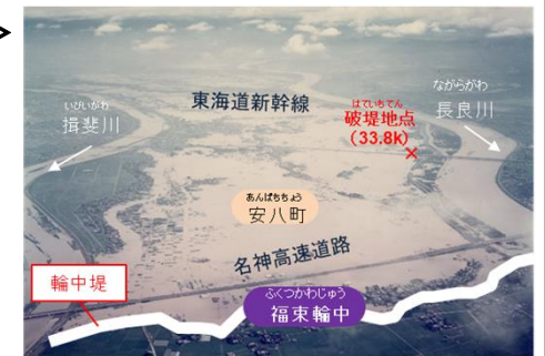
岐阜県輪之内町（福東輪中）
