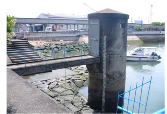
潮位計等の観測施設の設置
