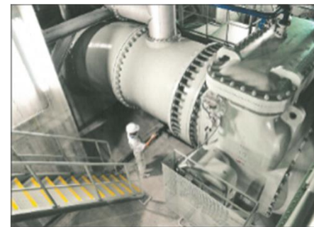
雨水ポンプの整備
