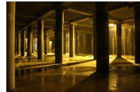
貯留施設の整備
