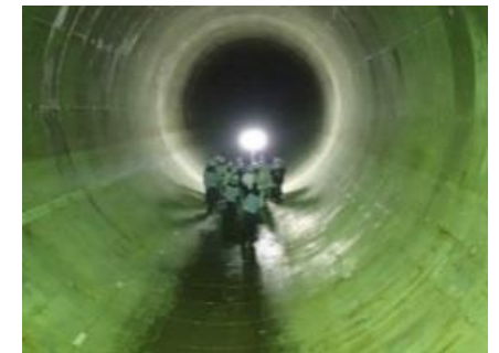
雨水貯留管の整備
