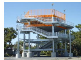
津波避難タワー
