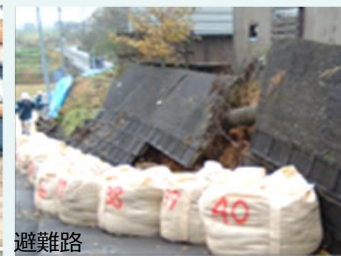
擁壁の防災対策
