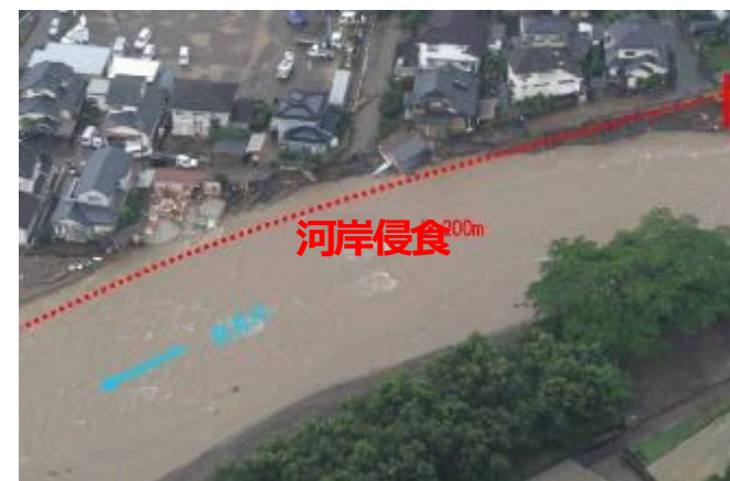
河岸侵食に伴う家屋倒壊等
