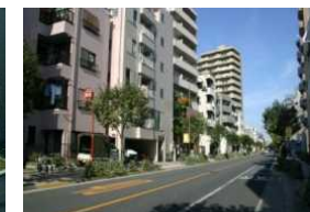
沿道建築物の不燃化
