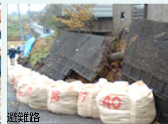
擁壁の防災対策
