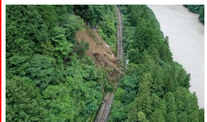
なかいさむらい こわだ JR東海 飯田線 中井侍駅～小和田駅 土留壁崩落
