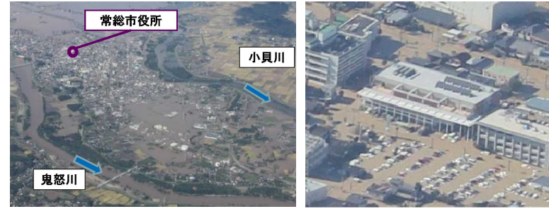
平成27年9月関東・東北豪雨において常総市役所本庁舎が浸水、非常用電源設備（屋外設置）の使用不能
