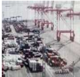
⑥ 神戸港六甲アイランドにおける浸水被害 (兵庫県神戸市)
