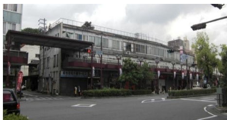
防火建築帯 (岐阜県大垣市)
