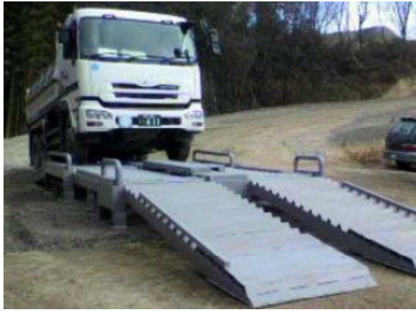
写真② 周辺道路の散水・清掃状況、タイヤ洗浄機の設置
