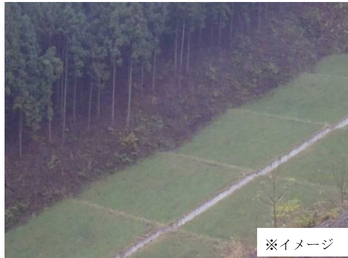
図 5-1 植生による法面保護工
