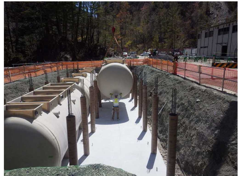
実際に設置した高度浄化装置
