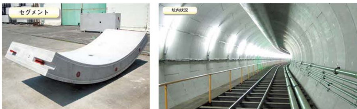
写真 7-5 コンクリートセグメント
