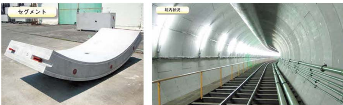
写真 7-4 コンクリートセグメント
