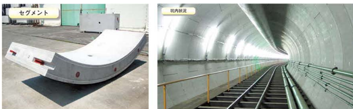
写真 7-4 コンクリートセグメント
