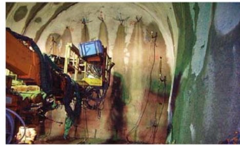
写真 薬液注入工の施工例
