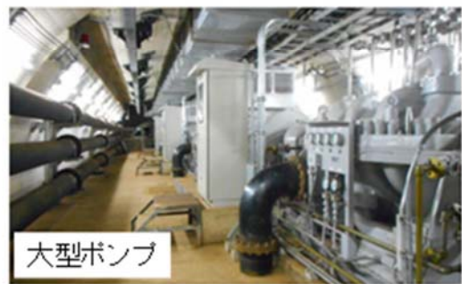
図 4.29 青函トンネルの排水設備
