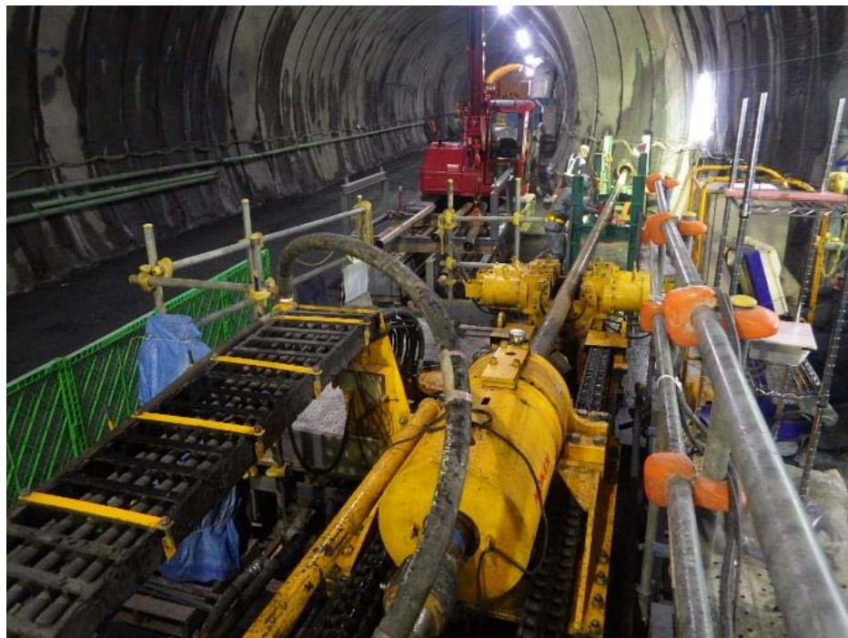
写真 1.1 トンネル坑内での先進ボーリングの実施状況
