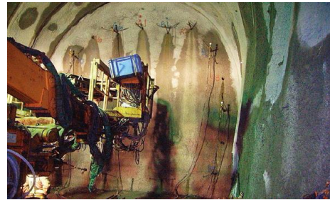
写真 薬液注入工の施工例
