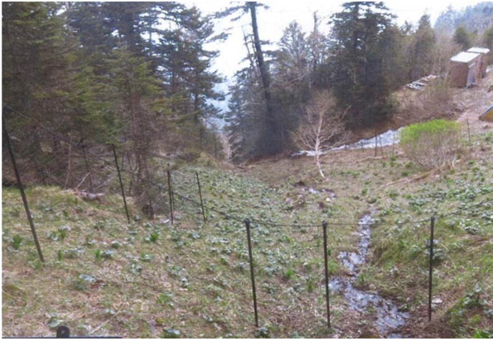
図 3.3 獣害防止策の設置例（千枚小屋付近）
