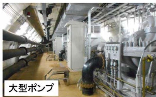
図 5 青函トンネルの排水設備
