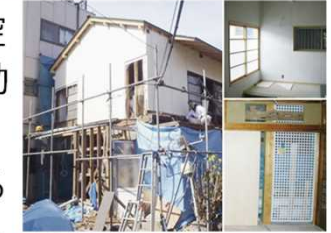
耐震・防耐火補強工事のイメージ
