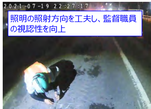
【測定箇所のライトアップ】
