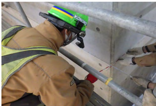
【立会状況（現場側）】
