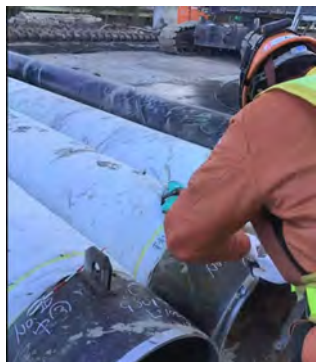
【立会状況(現場側)】
