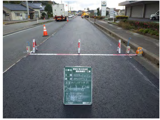
【昼間施工状況】
