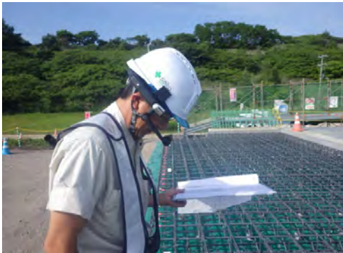
【立会状況 (現場側)】
