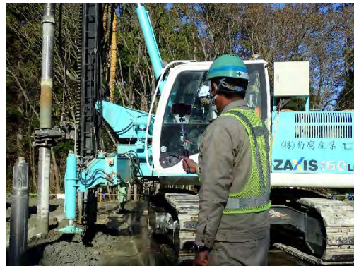
【立会状況 (現場側)】
