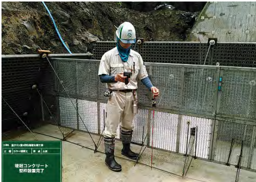
【立会状況（現場側）】
