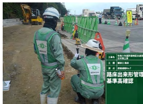
【杭打ちアプリを活用した基準高確認】
