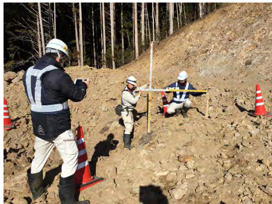
【立会状況（現場側）】
