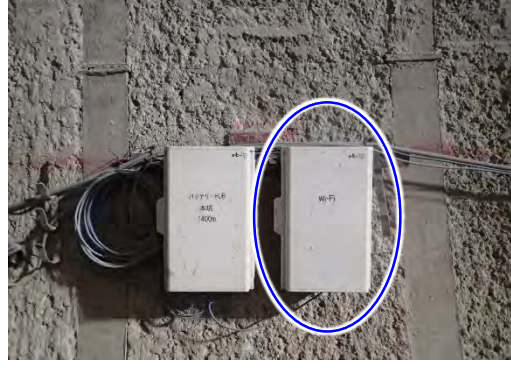
【遠隔臨場用の坑内Wi-Fiの設置（現場側）】
