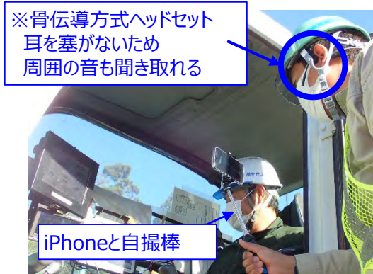
【遠隔臨場現場側の全システム】
