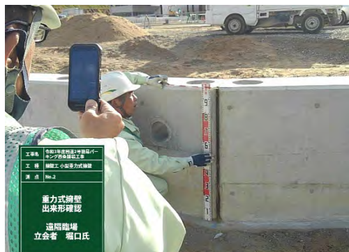
【擁壁出来形立会状況（現場側）】
