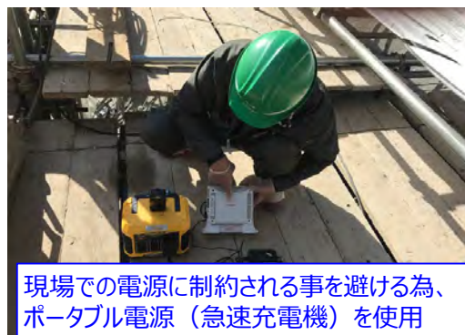
【屋内電波改善装置、ポータブル電源】
