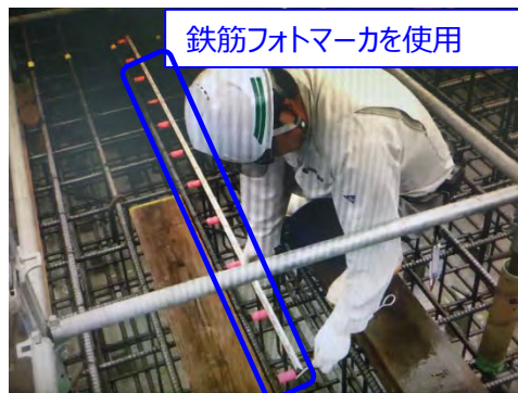
【立会状況(現場カメラ側)】
