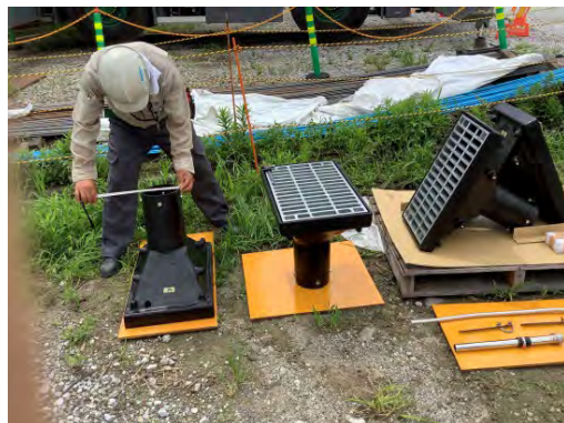
【立会状況 (現場側)】
