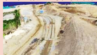
測量、出来高管理
