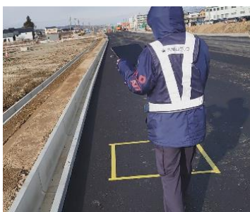
側溝計測
