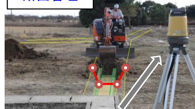
RTKGNSSやTS等による出来形管理
